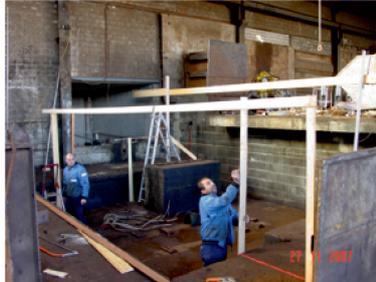
... auch darunter Stand der Technik. Das Betonfundament der neuen Sierra-Schere wurde schwimmend gefertigt um störende Vibrationen zu minimieren. Über den gesamten Betonbereich wurden ausserdem Stahltafeln montiert und durchgehend verschweisst um bei einer Leckage das Oel auffangen und ein Eintreten in den Beton verhindern zu können.
