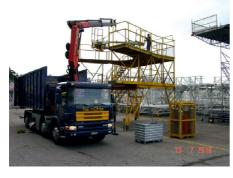
Aus Sicherheitsgründen haben wir unseren Demonteur Lorenz Schneider mit einer Absturzsicherung ausgerüstet (diese Gurteinrichtung ist ähnlich denen von Bergsteigern oder Fallschirmspringern). Mit 15 Metern Zugleine
