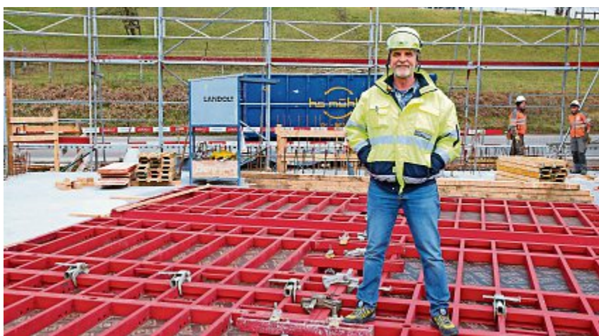
Armin Mühle auf der Baustelle des entstehenden «Eco-Centers». duf
